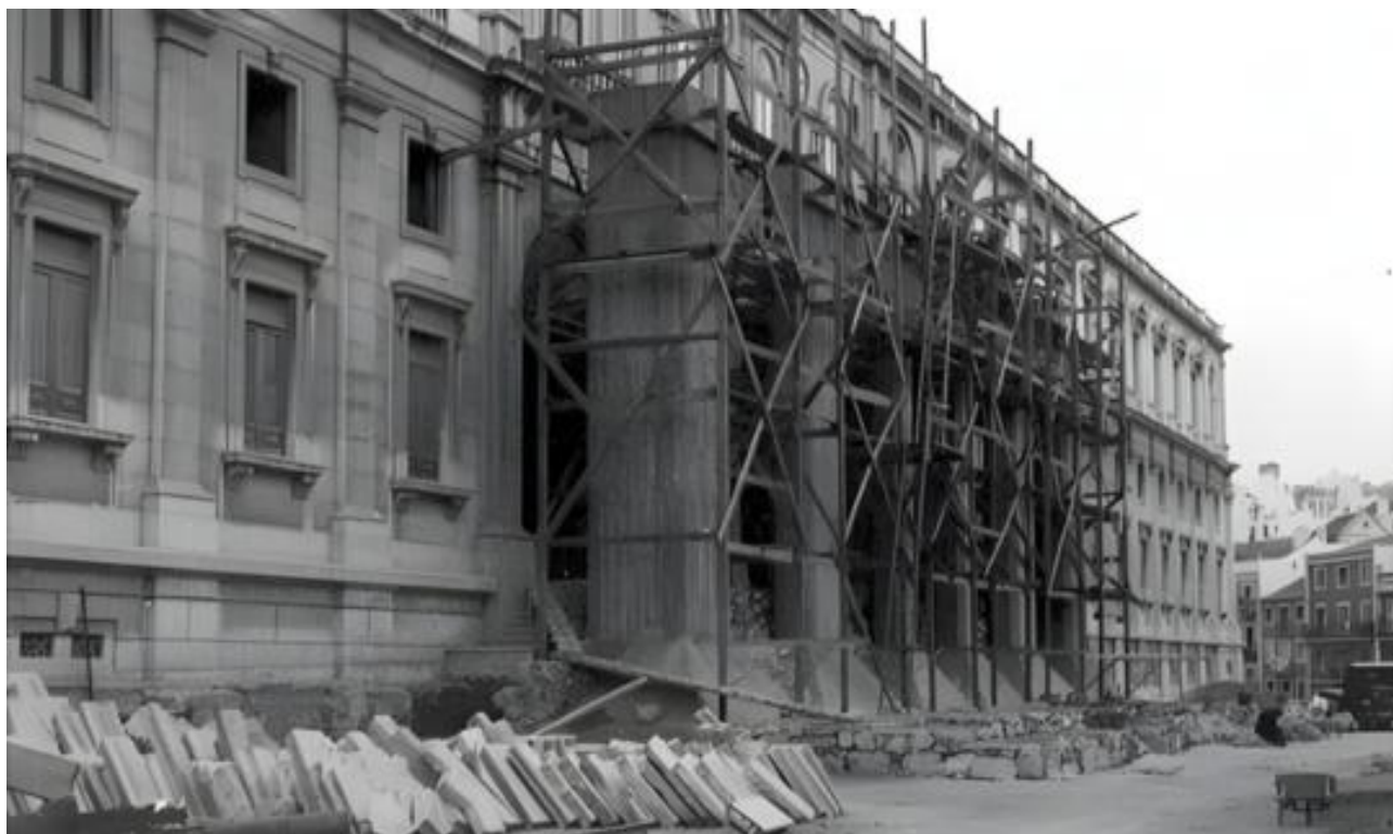
Fundações e Colunas do Corpo Central da Assembleia Nacional, Lisboa (1934)
